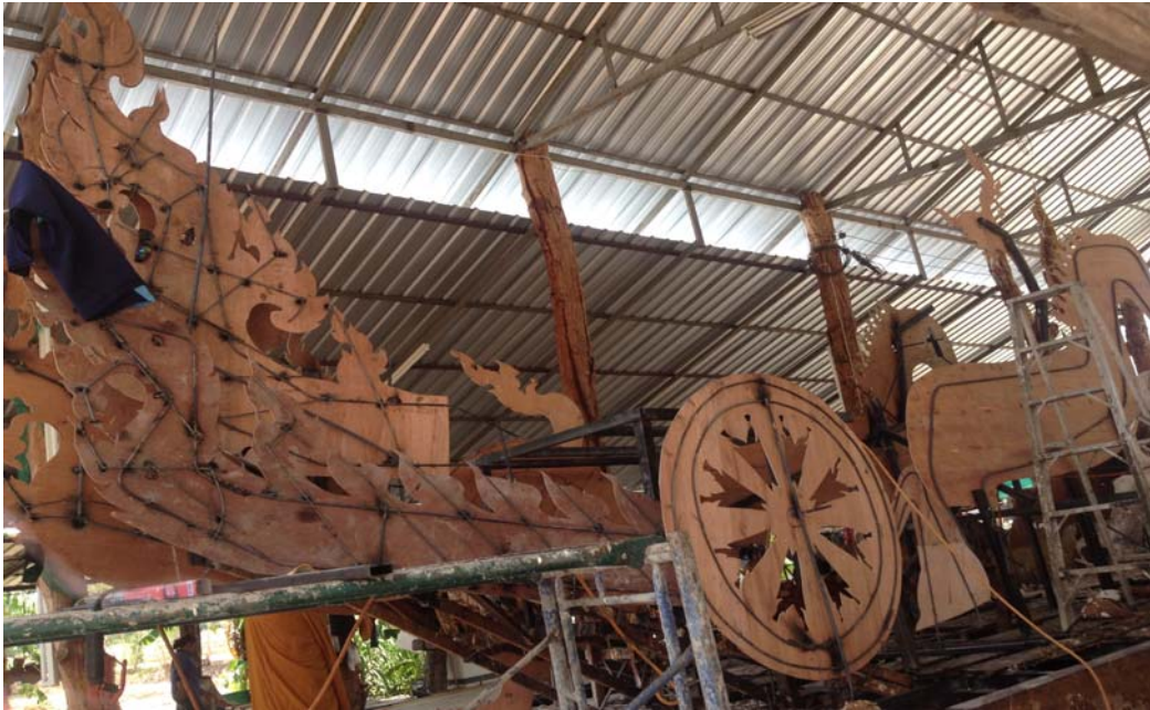
ภาพ 10 เสริมเหล็กแกนกลาง ขึ้นโครงสร้าง
