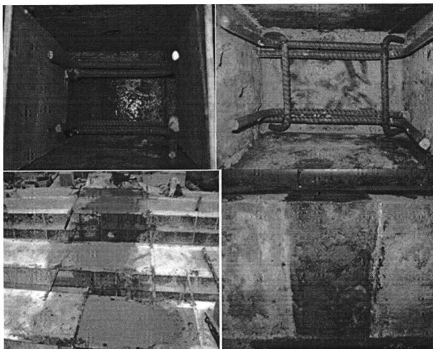
ภาพที่ 3.19 บริเวณของรอยต่อแบบเปียกก่อนและหลังการเทคอนกรีต
