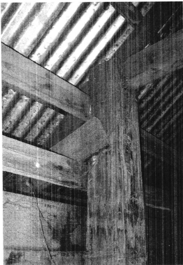
“การบากหูโป่งหรือหูกะต่าย” หมายถึง ซื่อมากรับจันทน์ในเสา
