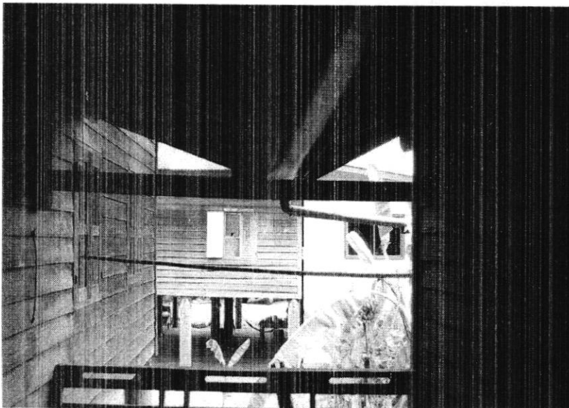
ทำหลังคาคลุมชานข้างพร้อม รางน้ำตรงกลาง
