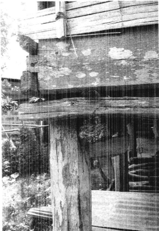
แสดงให้เห็นกะทอค และเดือย (ปิง) จากเสา รับคานกลม
