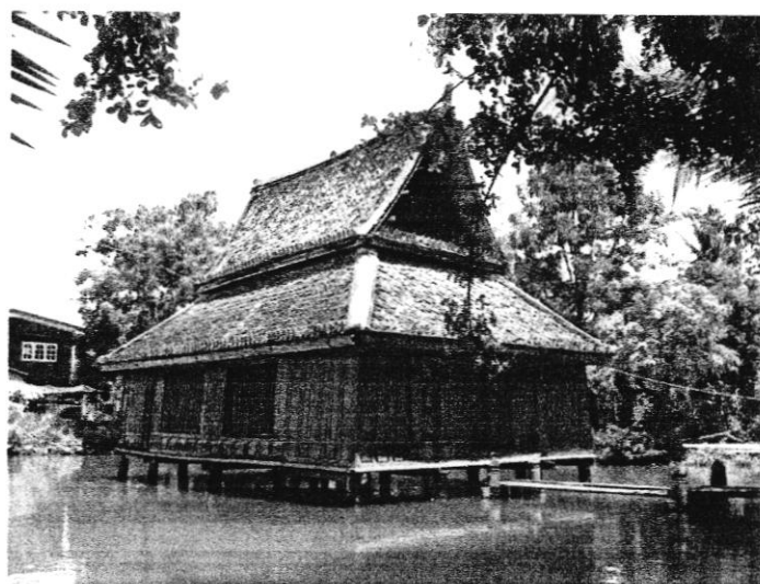
ภาพที่ 4-3 หอไตรกลางน้ำแบบพื้นเมืองอีสาน ตั้งอยู่กลางสระน้ำรูปสี่เหลี่ยมผืนผ้าทางด้านหน้าอุโบสถหลังเก่า
