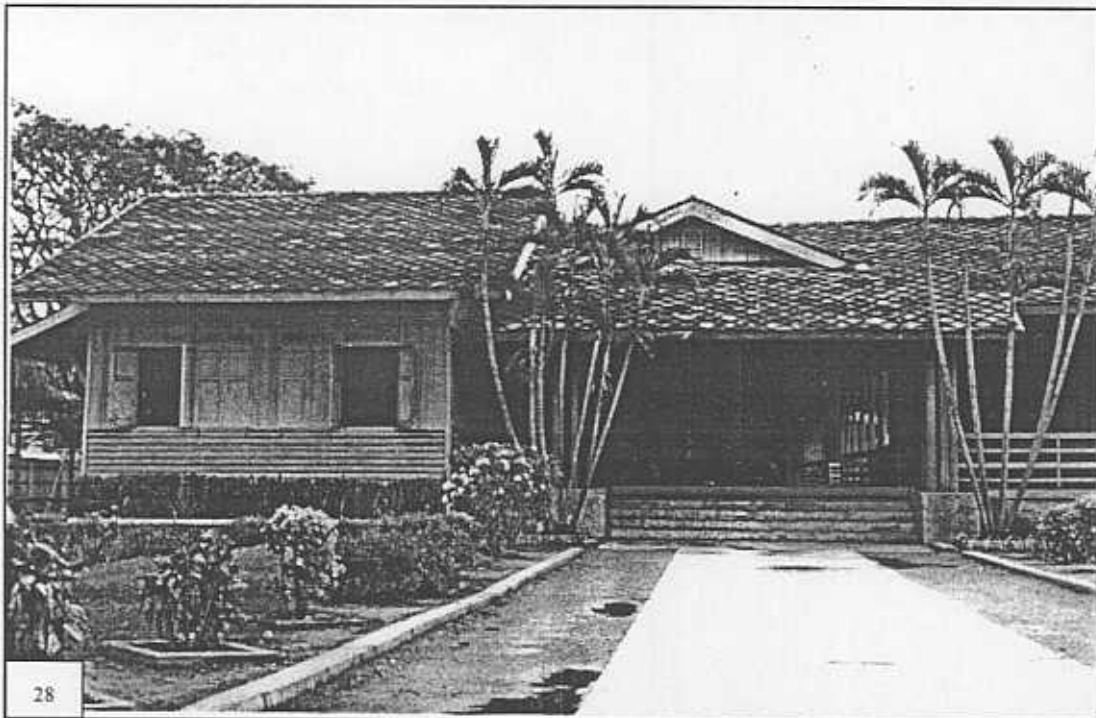
รูปที่ 28-28 อาคารเรียนโรงเรียนอนุบาลอุบลราชธานีในอดีต
