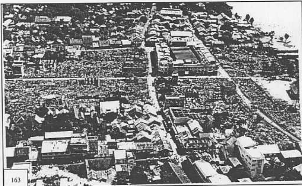
รูปที่ 162-163 สภาพบริเวณภายหลังไฟไหม้เมืองราชธานี (พ.ศ. 2503)
