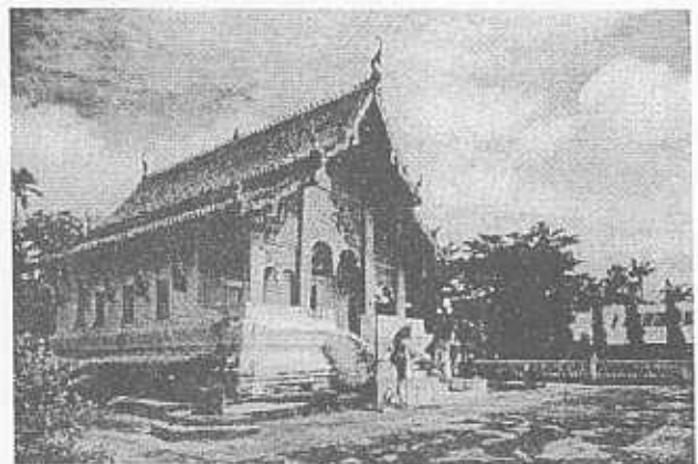
หลังคาเป็นไม้เนื้อแข็ง สด 2 ชั้น มุงด้วยกระดานไม้
