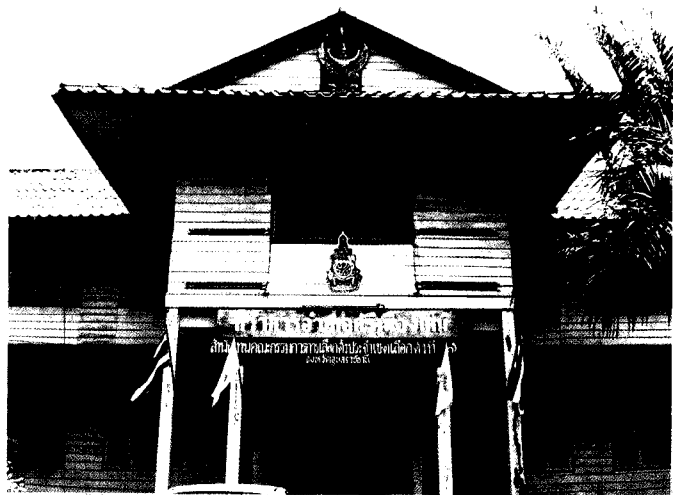
ที่ว่าการอำเภอศรีเมืองใหม่หลังเก่า สร้างเมื่อ พ.ศ. 2500
