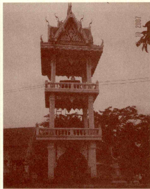
รูปที่ ๑๔ หอระฆัง-กลองเพล-โปงไม้โบราณ
