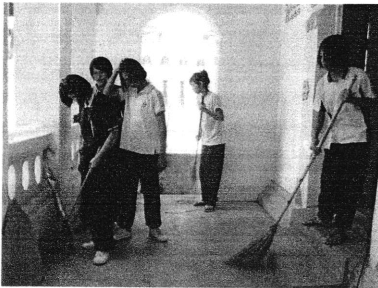
ผู้เข้ารับการอบรม ซึ่งส่วนใหญ่จะเป็นนักเรียนทั้งหญิงและชาย พร้อมอาจารย์อีก 2 ท่าน ได้ช่วยกันทำความสะอาดพื้น ทำความสะอาดผนังเพื่อลอกเอาสีพลาสติกที่ทาที่บนสุปแต้มและทำความสะอาดตำแหน่งที่มีคราบสกปรกจากน้ำฝนและชันกออก
