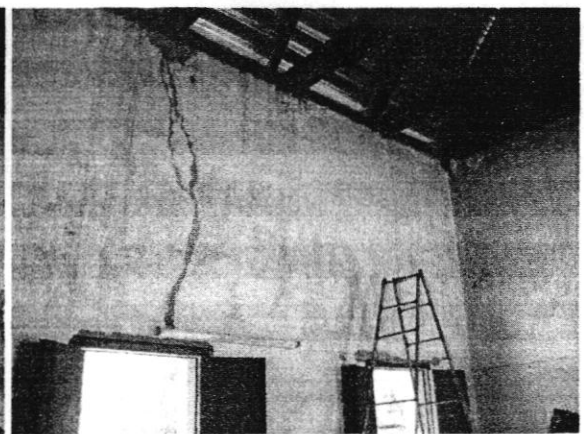
ภายในสิมวัดโนนศิลา ก่อนการทำความสะอาดจะเห็นคราบน้ำรั่วทั่วผนัง
