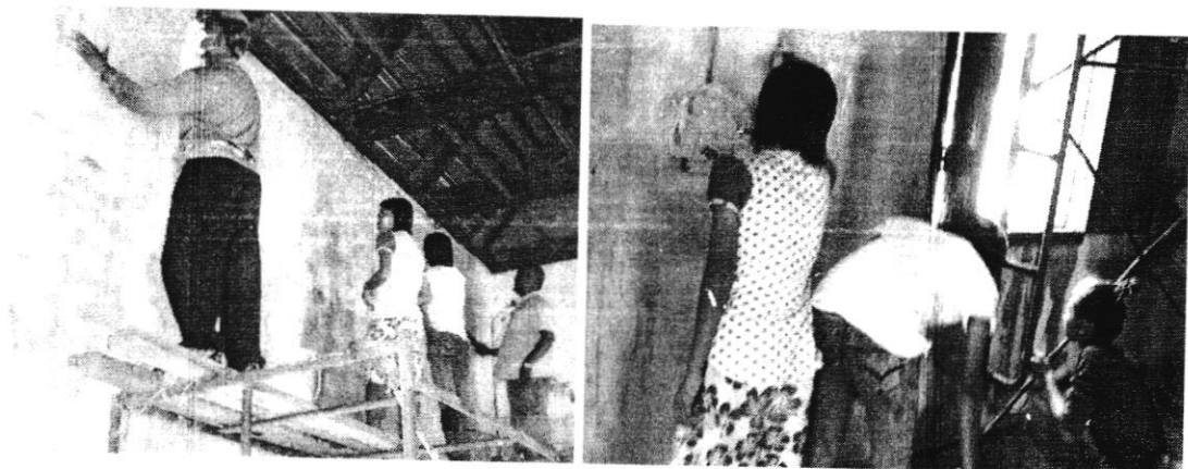
ผู้เข้าร่วมโครงการ ช่วยกันทำความสะอาดผนังฮูปแต้ม โดยใช้น้ำสะอาดชุบฟองน้ำ
