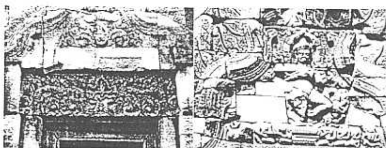
รูปที่ 3.17ค ทดแทนส่วนที่ขาดหายเพื่อให้องค์อาคาร หรือ โครงสร้างครบถ้วน
