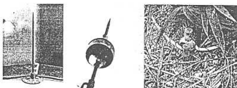
รูปที่ 3.20 ส่วนประกอบของสายล่อฟ้า
