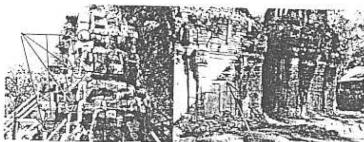
รูปที่ 3.16ข ตัวอย่างการผูกมัดโบราณสถานด้วยลวดเหล็ก
