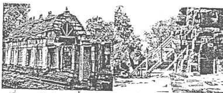
รูปที่ 3.16ก ตัวอย่างการค้ำยันโบราณสถานด้วยโครงไม้ หรือ โครงเหล็ก
