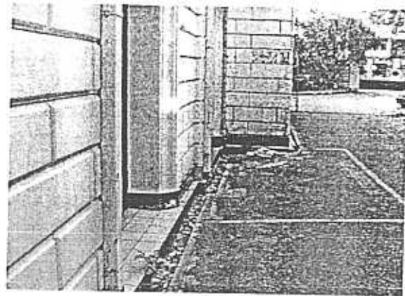
รางรับน้ำจากหลังคาติดกับอาคาร
