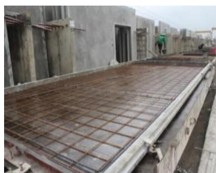
(ข) เสริมเหล็ก
