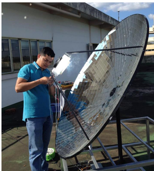
ภาพที่ 3.12 การติดตั้งเครื่องผลิตไฟฟ้าเพื่อทดสอบรับพลังงานแสงอาทิตย์
