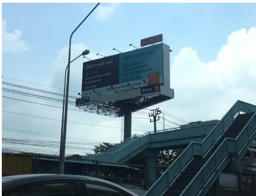
ภาพที่ 2.4 ป้ายโฆษณารูปทรงสามเหลี่ยม ชนิดเสากลมขาเดี่ยว
