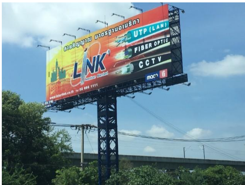
ภาพที่ 2.7 ป้ายโฆษณารูปทรงสี่เหลี่ยมผืนผ้า ชนิดเสาโครงถักขาเดียว
