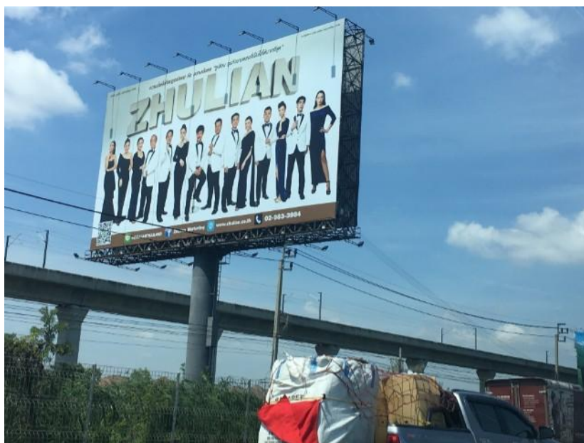
ภาพที่ 2.2 ป้ายโฆษณารูปทรงสี่เหลี่ยมผืนผ้า ชนิดเสากลมขาเดี่ยว
