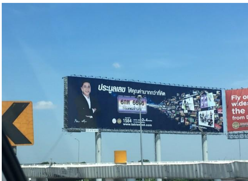
ภาพที่ 2.6 ป้ายโฆษณารูปทรงสี่เหลี่ยมผืนผ้า ชนิดเสากลมขามากกว่าหนึ่งคู่
