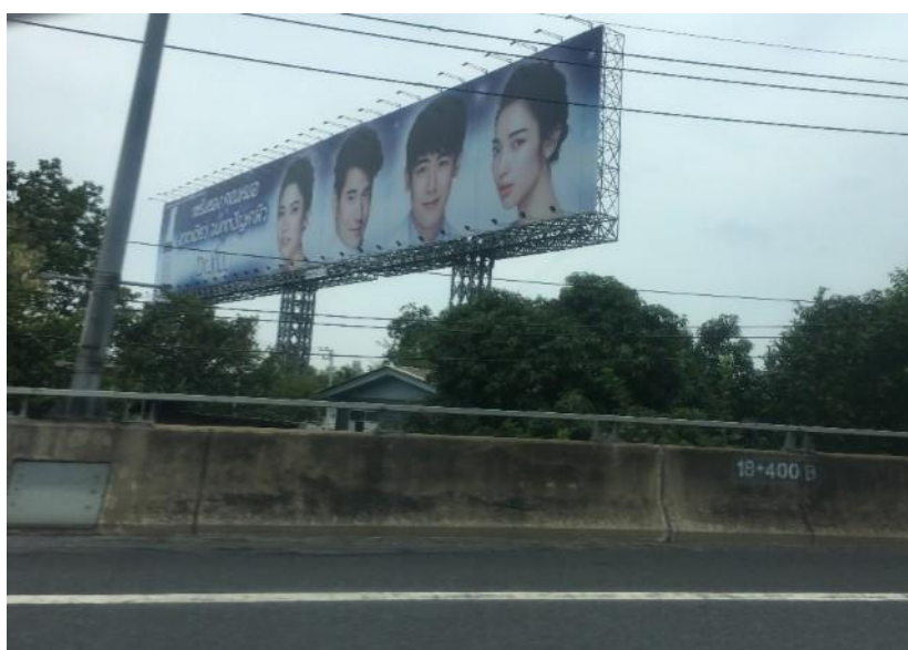
ภาพที่ 2.8 ป้ายโฆษณารูปทรงสามเหลี่ยมผืนผ้า ชนิดเสาโครงถักขาคู่
