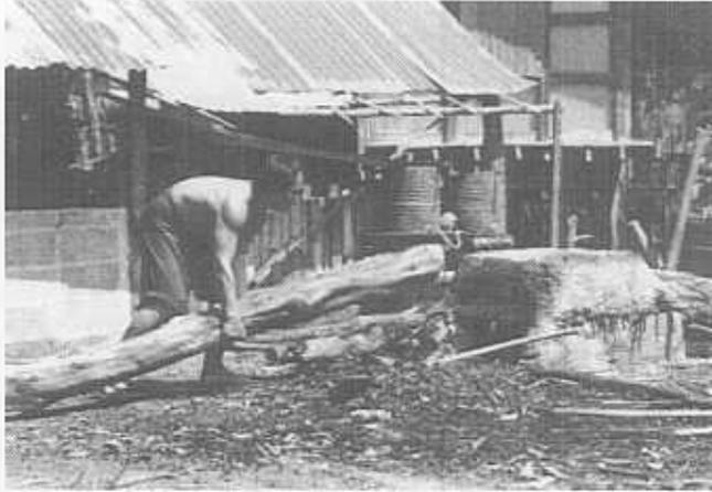
รูปที่ 2.20 นำเข้าที่ตากแดดแห้งแล้วมาสูม หรือเผาให้ร้อนด้วยฟืน เพื่อให้ขี้ผึ้งหลอมละลายออกจากเปลือกหมด
