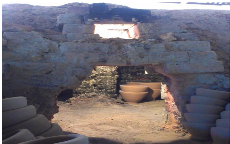
ภาพที่ 4.9 ลักษณะตัวเตาขนาดภายในกว้าง 2 X 2.5 เมตร
