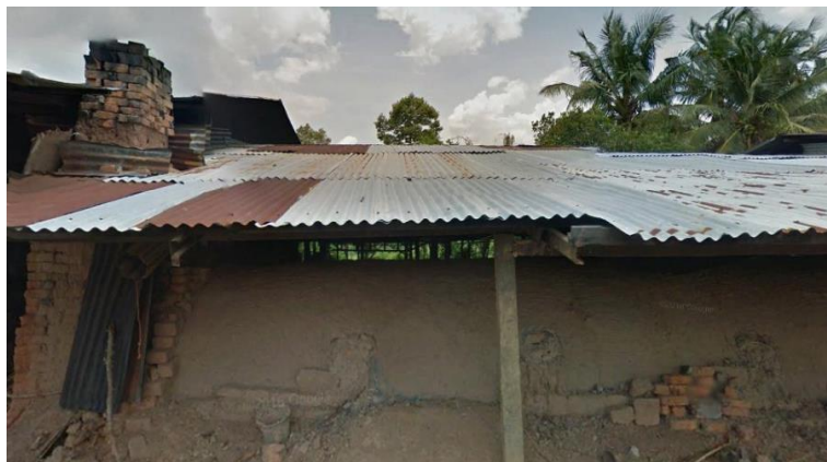
ภาพที่ 4.10 ลักษณะปล่องควันจะอยู่ส่วนท้ายของเตามีความสูง 3 เมตร
