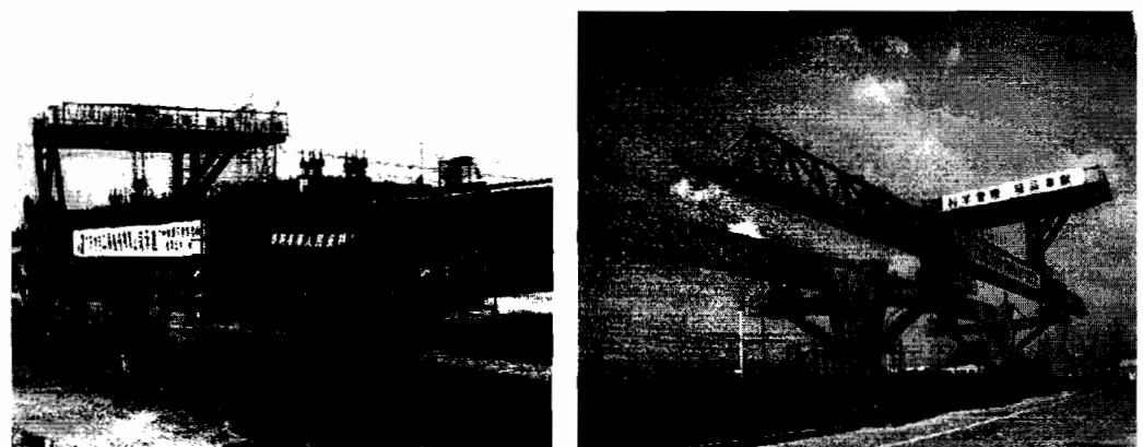
(ข) โครงเหล็กแบบ under slung
