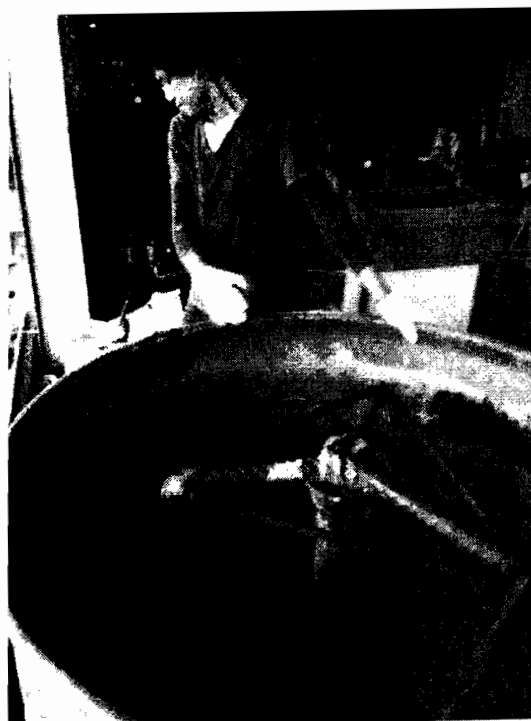
ภาพที่ 6.2 นำกากตะกอนผสมกับปูนซีเมนต์ อัตราส่วน ปูนซีเมนต์ 1 ถังกากตะกอน 4 ถัง น้ำ 2 ถัง
