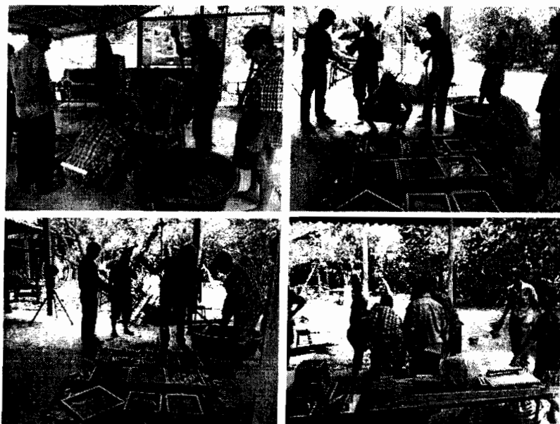
ภาพที่ ข.5 เทปูนซีเมนต์ที่ผสมจนเข้ากันแล้วเทลงในพิมพ์ไม้ที่เตรียมไว้
