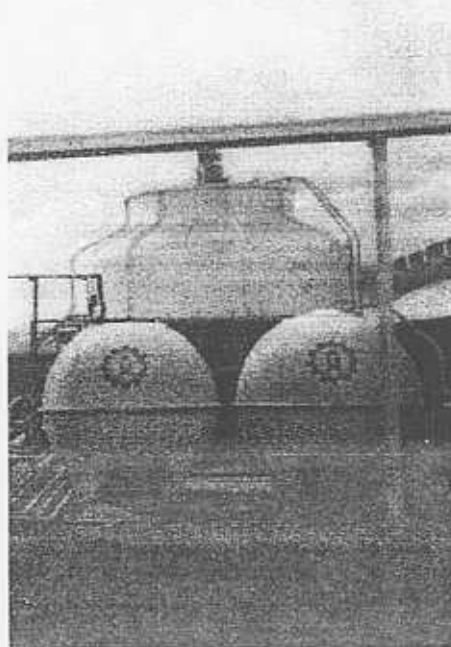
รูปที่ 2.3 ถังน้ำเย็นที่รับความเย็นจากระบบทำความร้อน เพื่อระบายความร้อนให้แก่น้ำจากตุลึงทาวเวอร์ที่โรงแรมแห่งหนึ่ง อ.เมือง จ.อุตรดิตถ์ (Ngamchauchit, Chuchai. 2003)
