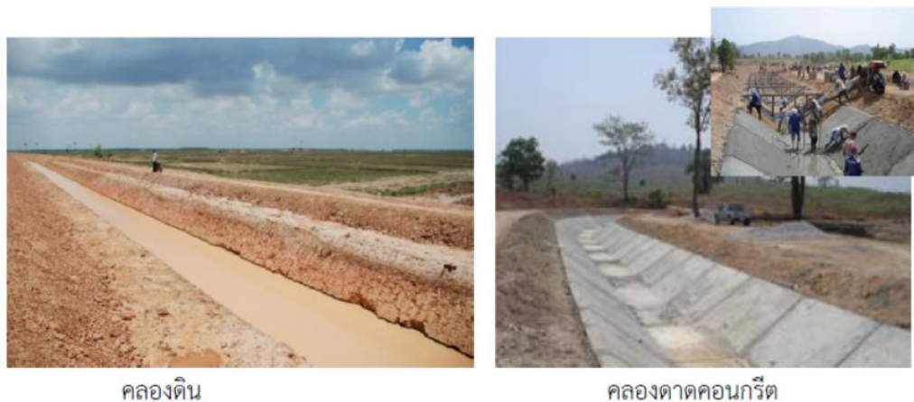
ภาพที่ 2.4 ลักษณะทั่วไปคลองส่งน้ำ [23]
