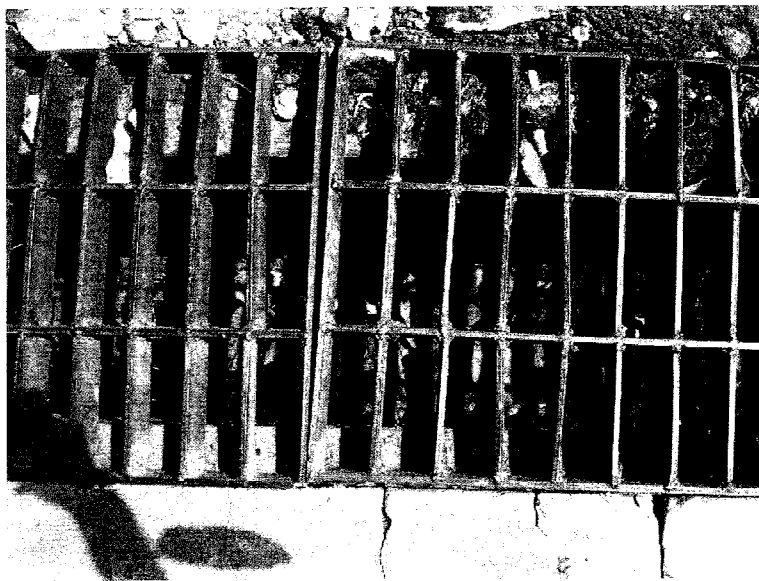
ภาพที่ 4.3 ระบบระบายน้ำฝน บริเวณด้านหน้าโรงพยาบาลเป็นแบบรางเปิด
