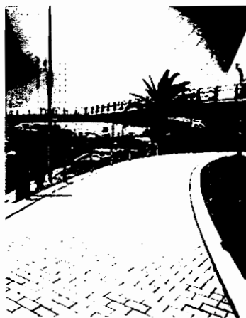
ภาพที่ 2.12 คอนกรีตปูผิวทางโดยบริษัทมิตรซูบิชิ [24]
