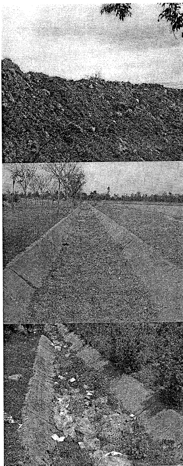
ภาพที่ 29 สภาพการชะล้างดินจากบ่อฝังกลบสะสมในลำรางระบายน้ำ
