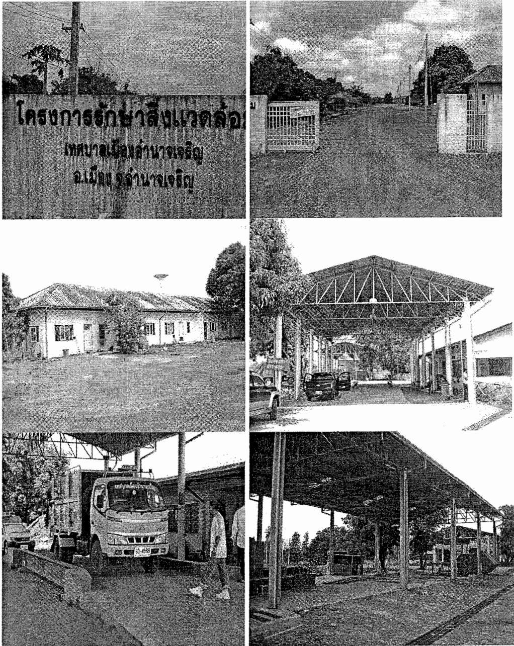
ภาพที่ 22 สภาพทั่วไปของพื้นที่โครงการกำจัดมูลฝอยส่วนของอาคารสำนักงาน
